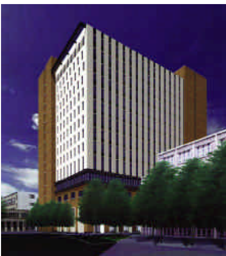
「2009年に竣工予定の新棟」
